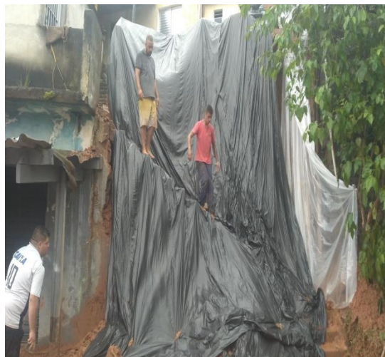
Foto 2 - Deslizamento de talude de aterro
